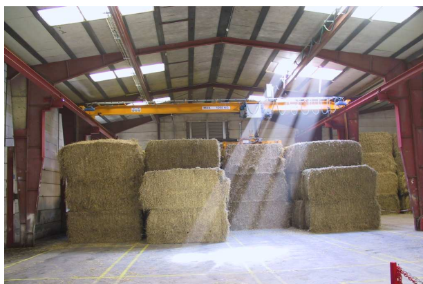
Halmlager med robotkran
